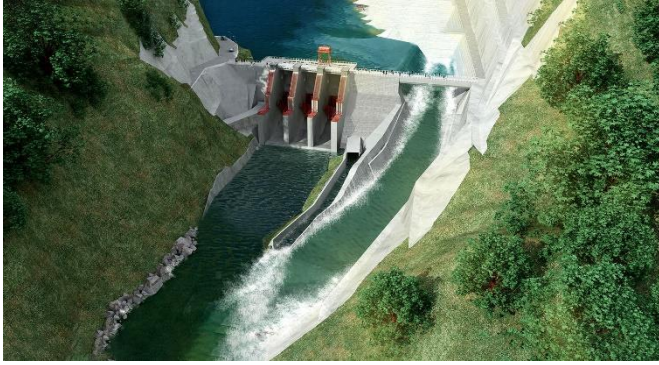
Hình 12: 2 dự án thủy điện của doanh nghiệp
