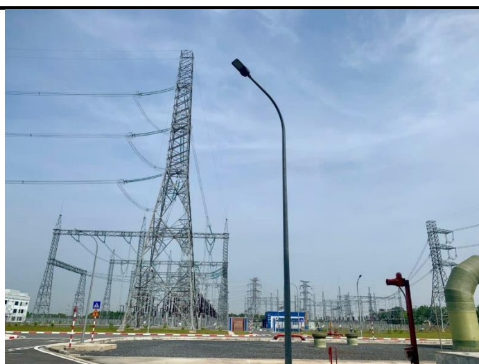
Hình 4: Nhà máy điện khí LNG NT3&4
