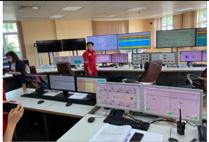
Hình 2: Nhiệt điện khí tuabin chu trình hỗn hợp thể hệ F của Siemens, có hiệu suất cao và phức tạp thấp
