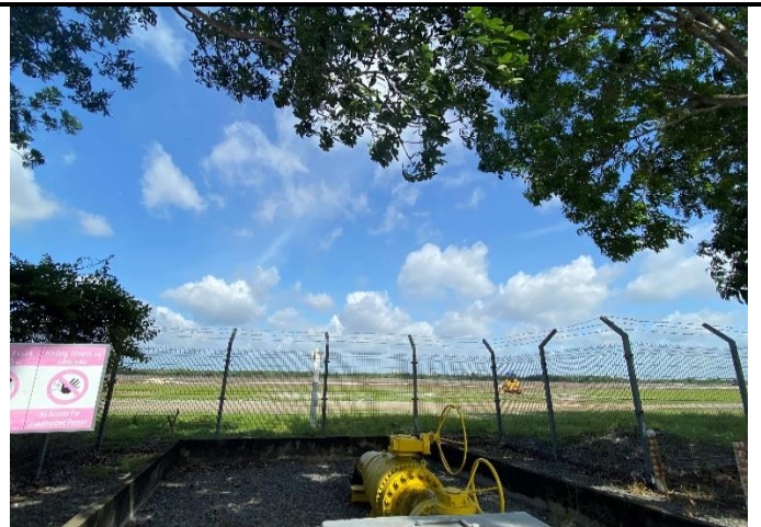
Hình 4: Hiện tại công tác giải phóng mặt bằng Nhơn Trạch 3&4 về cơ bản đã hoàn thành. Doanh nghiệp đã bàn giao phần diện tích nhà máy và một phần sân phân phối cho tổng thầu EPC
