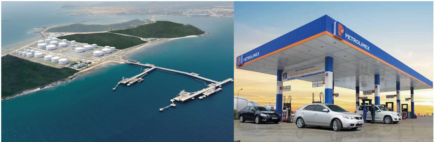
Kho cảng ngoại quan Vân Phong và Trạm xăng dầu của Petrolimex
