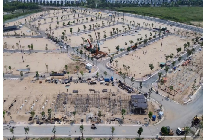
Hình 11: Dự án Izumi (phần khu Canaria) đang gần hoàn thiện hạ tầng nội khu
