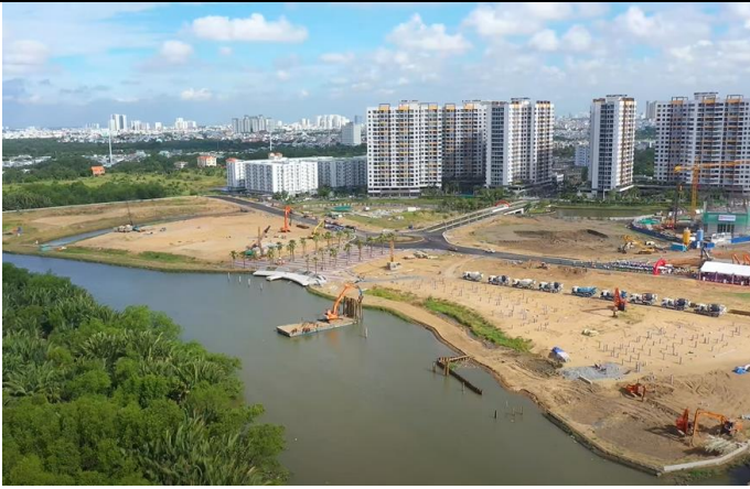
Hình 14: Dự án Mizuki: MP6-7-8, MP9-10 và Flora Panorama đang được thi công, kỳ vọng bàn giao từ cuối Q4/22
