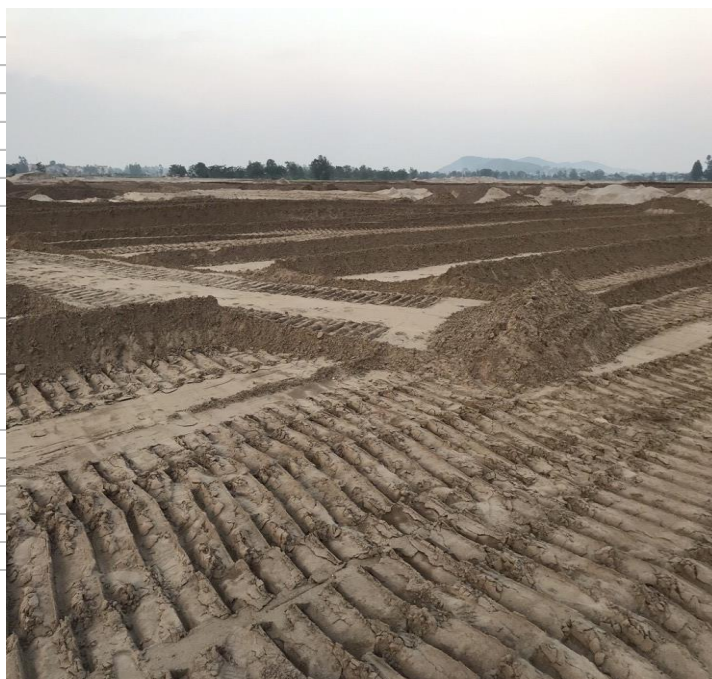
Hình 3: Giai đoạn 1 NSHL đang hoàn thiện cơ sở hạ tầng và san lấp nền (hiện trạng tháng 10/2020)
