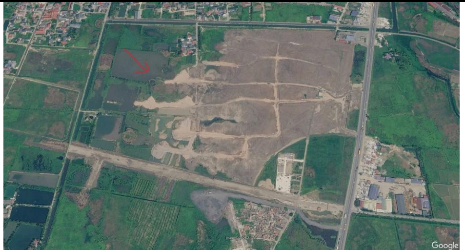
Hình 6: Tiến độ GPMB và xây dựng hạ tầng tại Trảng Duệ 3
