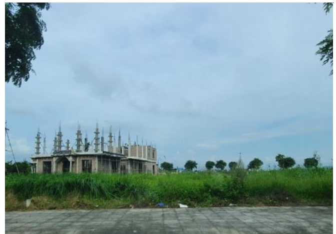
Hình 14: Một số căn đang được thi công tại KĐT Tràng Duệ
