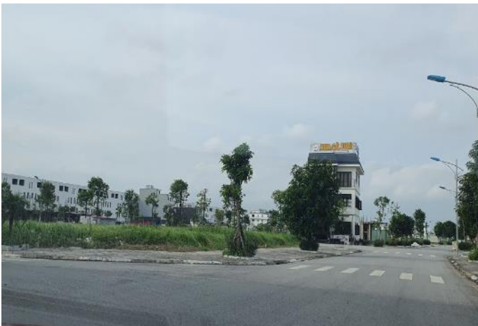
Hình 13: Đường nội bộ tại KĐT Tràng Duệ
