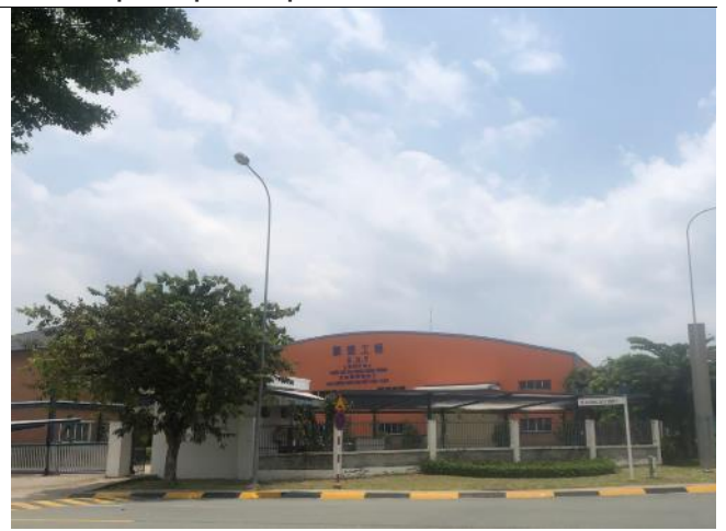
Hình 41: Dự án hiện hữu tại KCN VSIP I
