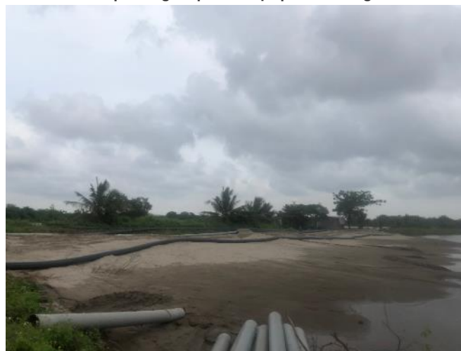
Hình 21: Khu vực đang được san lấp tại KĐT Trảng Cát
