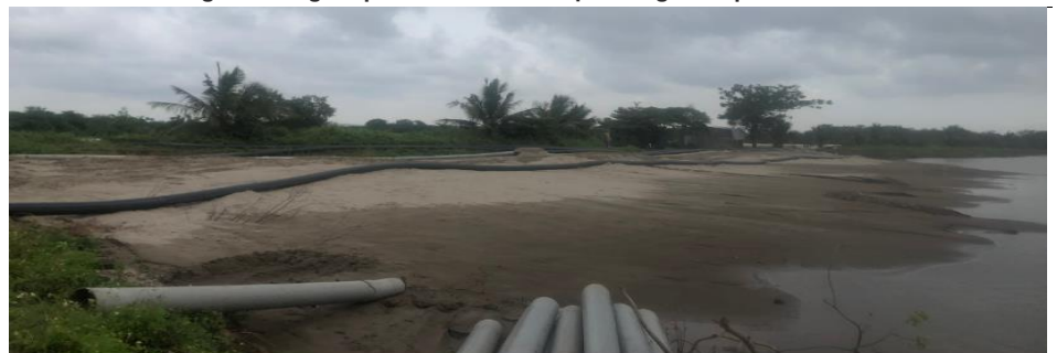
Hình 1: KĐT Tràng Cát đang được triển khai san lấp 80ha giai đoạn 1
