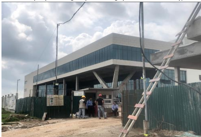
Hình 27: Một dự án đang được thi công tại KCN Nam Sơn Hạp Lĩnh
