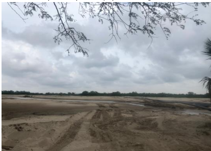
Hình 20: Khu vực đã được san lấp tại KĐT Trảng Cát
