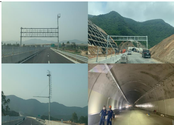
Hình: Phần hạ tầng đã được ELC thi công tại Diễn Châu – Bãi Vọt
