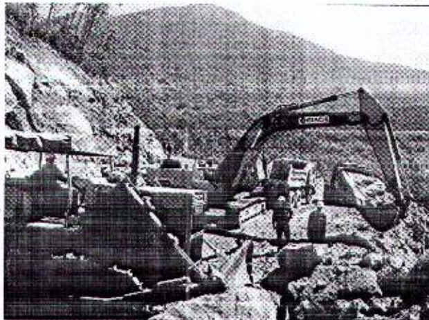
Thi công đường du lịch ven biển Sơn Trà – Điện Ngọc
