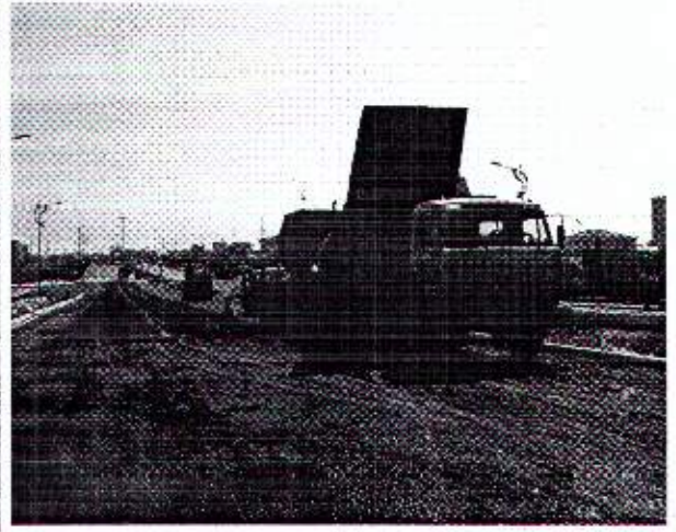
Thi công thảm bê tông công trình Cầu Rồng – Đà Nẵng
